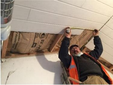
Afin de limiter les dégâts récurrents dus au gel sur les conduites des douches et des toilettes, le local technique des vestiaires du stade a été isolé.
