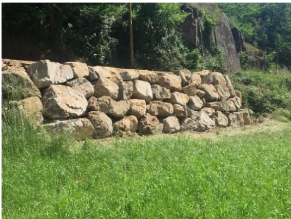
Gros chantier de voirie Route du Gô. Renforcement de la chaussée par la réalisation de deux empièvements et réduction d'un rocher pour améliorer la visibilité. Ces travaux ont été soustraits par PSC à l'entreprise Boudou Terrassement.
